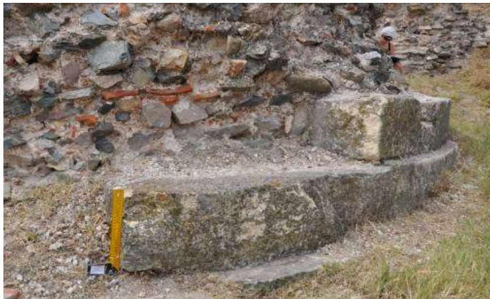
Fig. 8. Cetatea de Est - blocuri de calcar din paramentul turnului în formă de potcoavă de pe latura de nord-est / Eastern fortification – blocks of limestone from the northeastern side of the horseshoe-shaped tower (© 2011 Alexandrescu).
